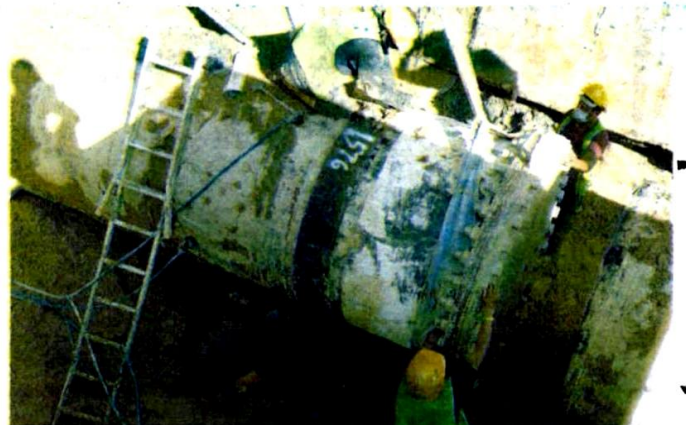
KONTRAKTOR Air Selangor melakukan kerja-kerja menaik taraf saluran air di Seksyen 15 Shah Alam, Selangor. - UTUSAN/ZULFADHLI ZAKI
