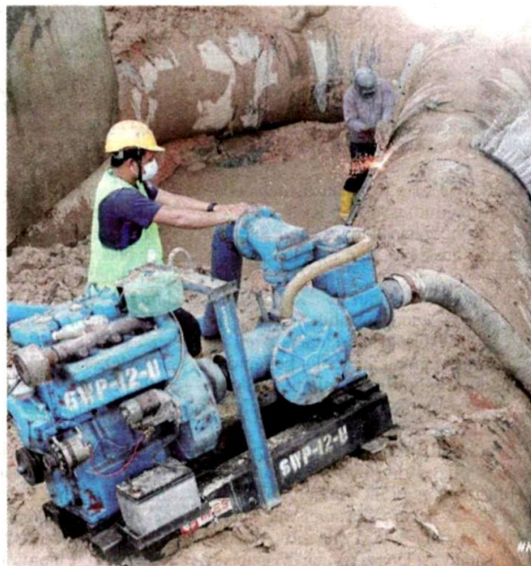
Kerja pengalihan dan penyambungan paip baharu di Persiaran Selangor Seksyen 15, Shah Alam sedang dijalankan.
