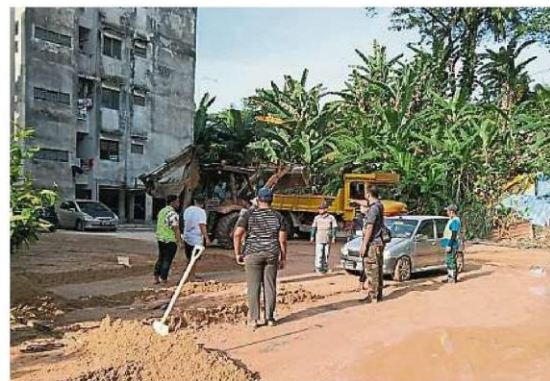
吉隆坡市政局工作人员正在清理组屋停车场。
